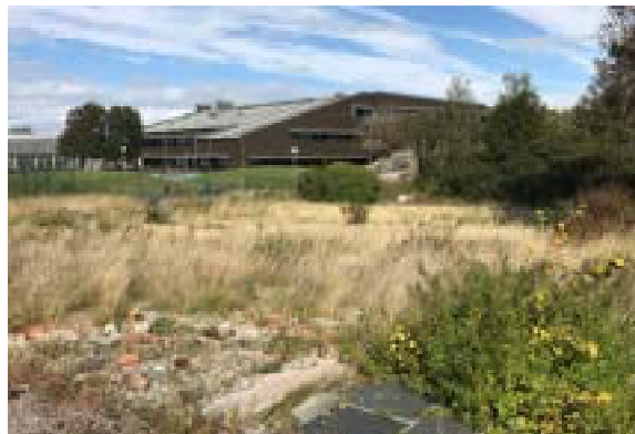
Vy från GA mot Brattebergsskolan
