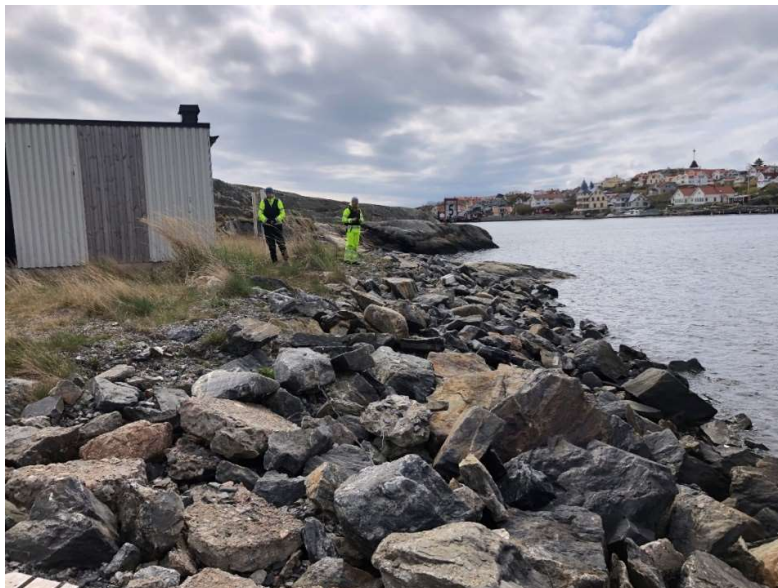
Figur 24. Befintlig pumpstation. (Foto: Svante Roupé)
