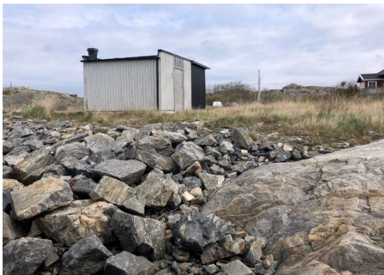
Figur 27. Befintlig pumpstation, strand med fyllnadsmassor samt berg i dagen. (Foto: Svante Roupé)
