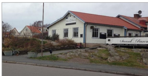
Figur 10. Restaurang inom fastigheten Öckerö Öckerö 2:123.
