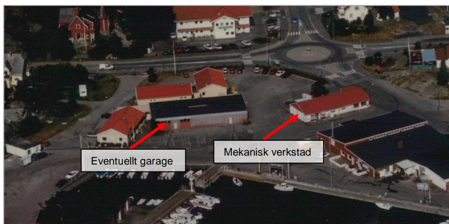
Figur 8. Flygbild av fastigheten Öckerö Öckerö 2:897 från 2000.
