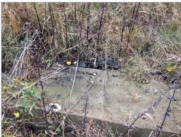
Figur 3. Asfaltsbitar och tillfört material inom fastigheten Öckerö Öckerö 2:487.
