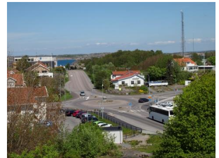
Cirkulationsplatsen mellan Hönövägen, Norgårdsvägen, Hålsövägen och Björnhusvägen inom planområdet.
