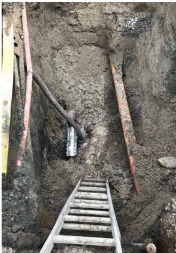
Lagning av vattenläcka på huvudledning
