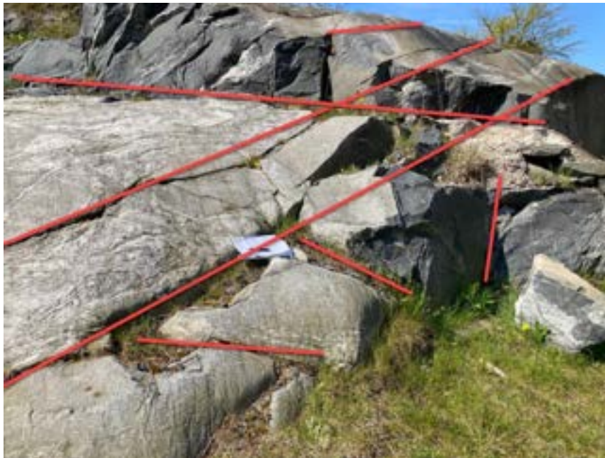
Figur 14 Berg med dominant sprickor i riktning ca 20 grader NW, markerad med röda linjer, och frakturer vinkelrätt sprickorna. Sprickorna är öppna, vittrade och fyllda med växande gräs och vegetation. Bild © Atkins Sverige AB
