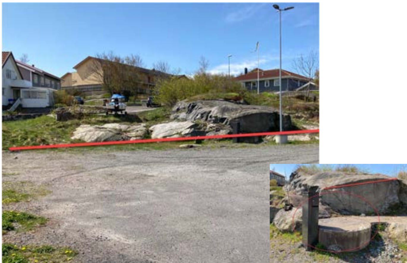
Figur 12 Tv: Den röda linjen visar ungefärlig gräns mellan berg i dagen och jämn mark (tidigare anlagd för skola enligt figur 10) på den östra delen av fastigheten, vy mot söder. Th: Brunn och elskåp i anslutning till berg. Bilder © Atkins Sverige AB.
