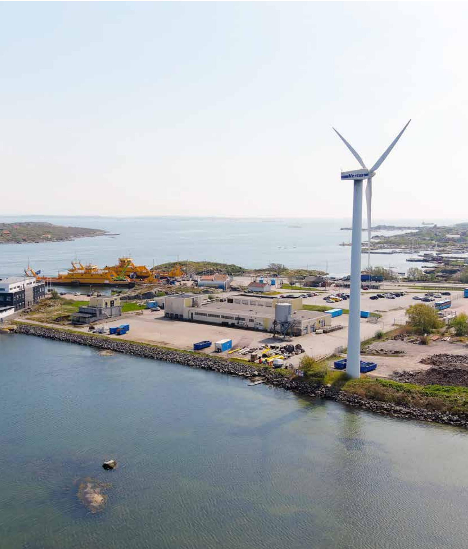
Reningsverket, Hönö Pinan.
