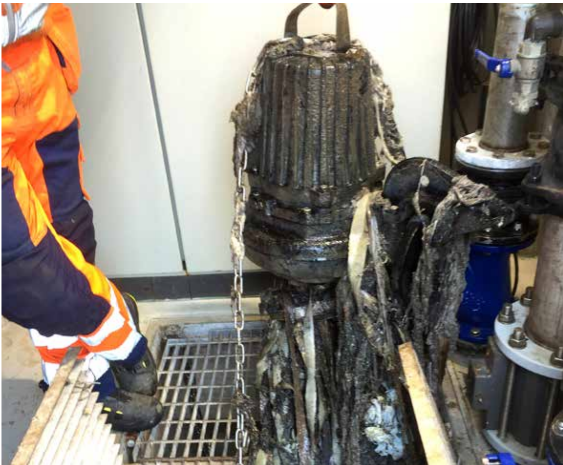
Driftstopp i en avloppspump åtgärdas.
